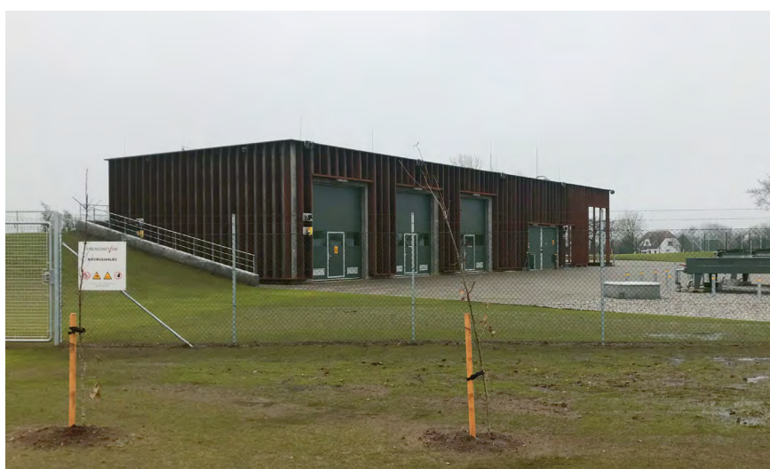
St. Andst kompressorstation. Foto: Energinet
