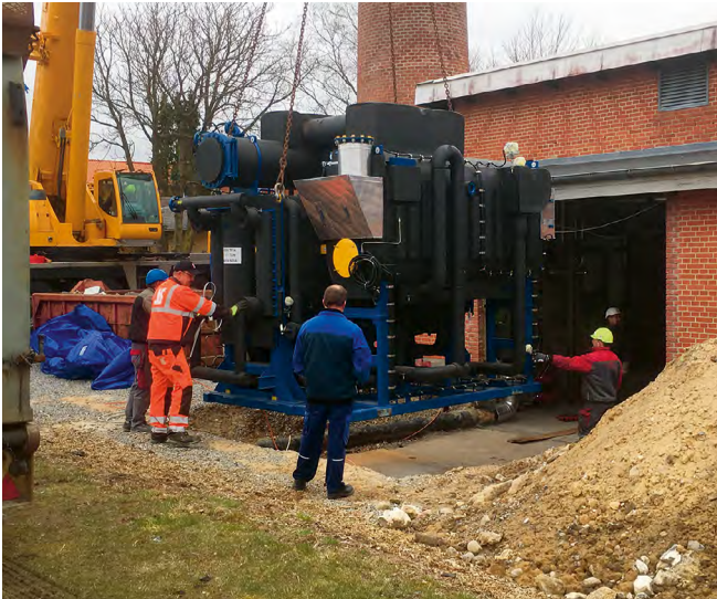
Figur 2: Direkte gasfyrte absorptionsvarmepumpe bliver bakset ind. (Klokkerholm, Hjallerup Fjernvarme). Foto: DGC
