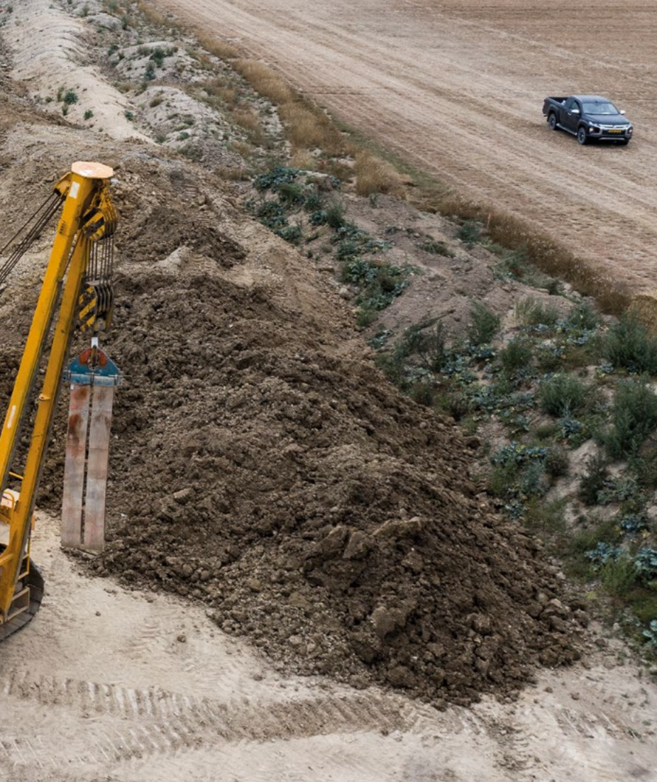
I alt 210 kilometer gasrørledning graves ned hen over Danmark, og i år vil der blive arbejdet i Jylland, på Fyn og på Sjælland. Billedet er fra arbejdet på Sjælland i 2020. Foto: Energinet/Palle Peter Skov
