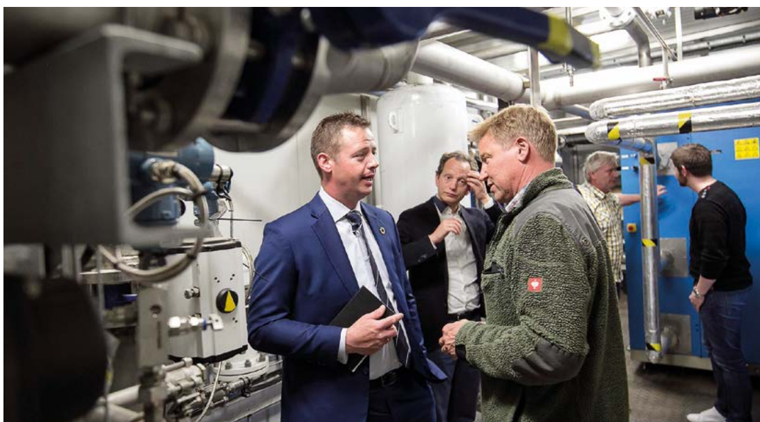
Jens H. Christensen forklarer Thomas Danielsen hvordan CO 2 -indholdet bliver fjernet i den rå biogas, inden den resterende metan sendes ud i naturgasnettet. Foto: Steen Don
